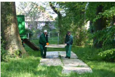
Der Einsatz unserer Bodenschutzplatten erfolgt oft in Parks und Gärten
