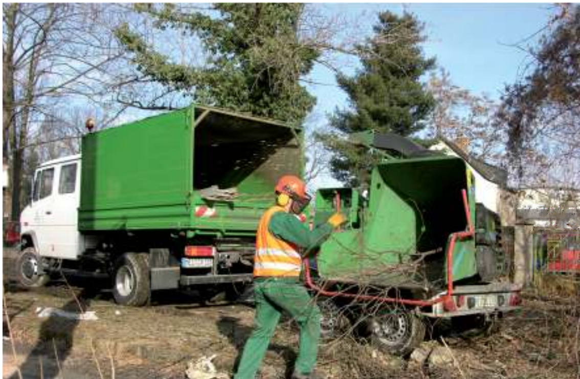
Beräumung von Baumpflege- und Baumfällbaustellen mit modernen Buschhackern
