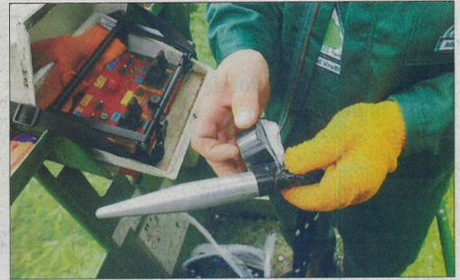
Eine Ahle wird zunächst an Hohltäu befestigt, um das Tau dann besser in den Schutzschlauch einfädeln zu können.
