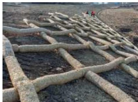
Diese rautenförmig verlegten Strohwürmer sollen verhindern, dass der neu aufgebrachte Boden wieder abgetragen wird. (BILD: PETER WÖLK)
