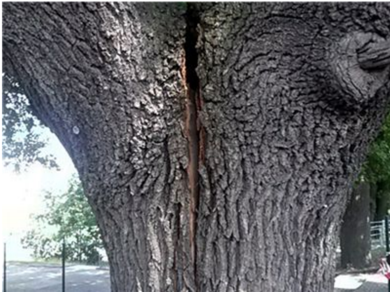
Zwischen den beiden mächtigen Kronenästen der Eiche bildete sich gestern dieser Riss.
